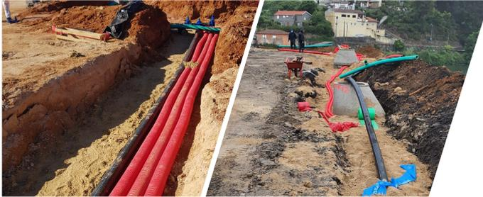
Se deben utilizar materiales adecuados para rellenar la zanja. Para la ejecución de la zanja y primeras capas se debe utilizar material de baja granulometría. Se debe tener extremo cuidado y rigor en compactación, para asegurar el llenado completo de las corrugas. La compactación de los materiales seleccionados debe realizarse por capas y con el máximo cuidado para evitar una deformación excesiva del tubo a corto/medio plazo.
