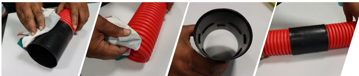
Al realizar la unión, las superficies deben estar limpias, los cortes en la tubería no deben presentar rebabas y deben ser eliminadas si existen. La unión debe introducirse en el tubo hasta el centro de esta, no siendo necesario aplicar lubricantes ni adhesivos. necessário aplicar lubrificantes ou adesivos.
